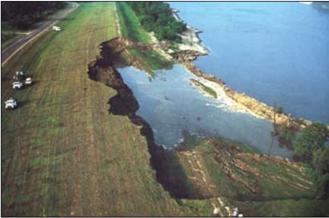
Diverses raisons peuvent être à l'origine de la rupture des levées. Haut : une rupture soudaine dans la vallée centrale de Californie, en 2004, a provoqué des dégâts de 90 millions de dollars ; la raison exacte reste inconnue, mais un mauvais entretien pourrait être en cause (photo : département de l'Eau de Californie). Bas : un glissement de terrain massif en Louisiane en 1983.
