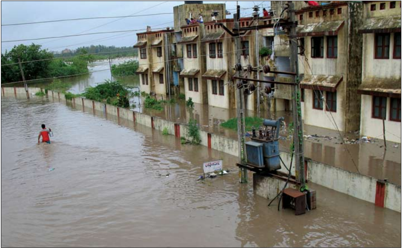
La rupture de barrage qui a inondé la ville de Surat a provoqué la mort de 120 personnes, des milliers d'animaux, et causé des milliards de dollars de dégâts.
