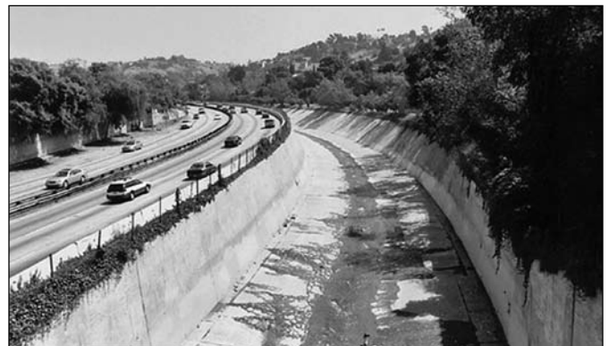
Un exemple extrême d'ingénierie hydraulique : la rivière de Los Angeles a été réduite à un chenal de béton.
